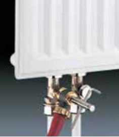
Слив и заполнение системы через «Multiflex V»
