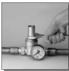
2. Отвинтите колпак, используя ключ на 32 мм.
