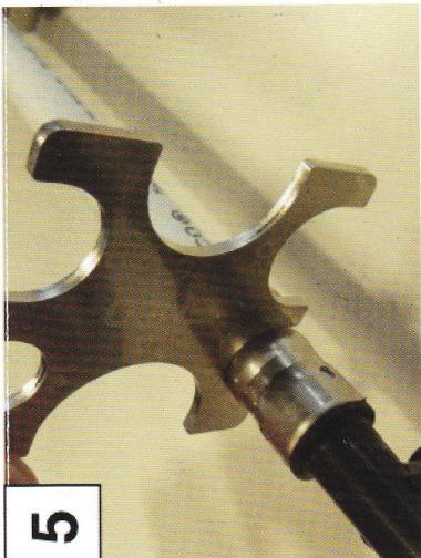
5. Draai het meetinstrument  $360^\circ$  rond de indruk op de pershuls en zorg ervoor dat ze beiden tijdens deze handeling perfect bij elkaar aansluiten zoals in stap 4. In geval van mislukking (bijv. te veel afstand, een belemmering, ...) is er iets mis met de persing van de koppeling. Indien dit het geval is adviseren we u een volledig nieuwe persverbinding te maken en de persmachine samen met de persbek te controleren.
